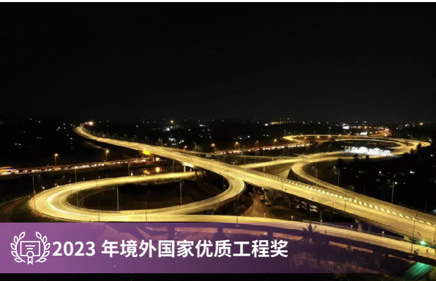
斯里兰卡科伦坡外环快速路工程
