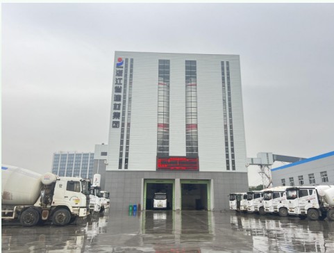
国内首个绿色高效固碳混凝土搅拌站
