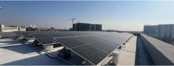
浙北基地厂房屋面光伏板建设
